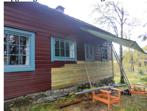
Utskifting av roten kledning i silregn
